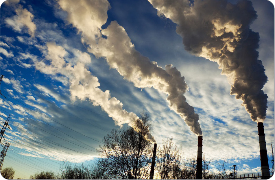
دود سیاه از دودکش‌های یک کارخانه در استان آذربایجان غربی، در شمال غربی ایران.
