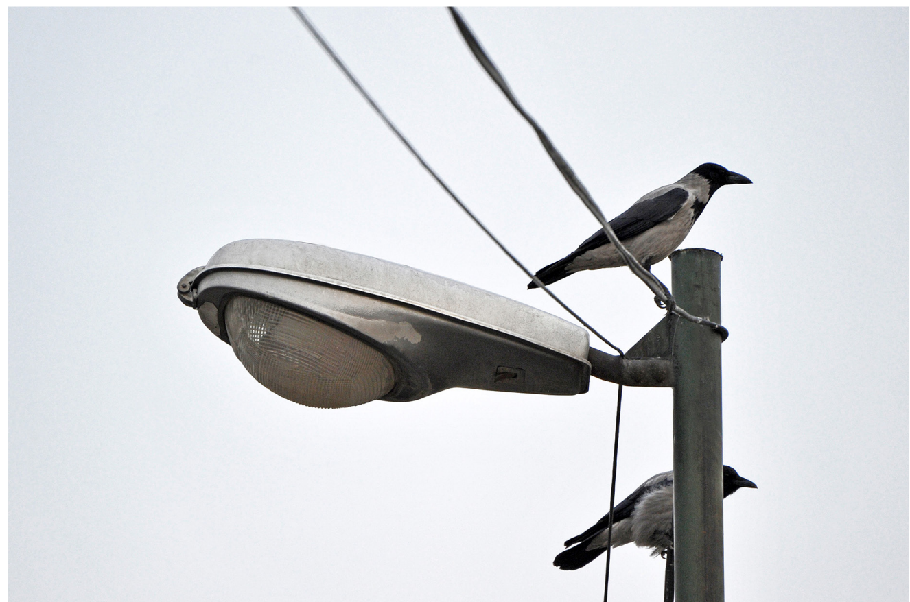
جریان گرما در رگ‌های خاموش برق. بی تردید کم آبی سرزمینی، عدم مدیریت صحیح آب‌های سطحی، نساختن نیروگاه‌های برق آبی جدید و نبود فرهنگ سازی مناسب برای جلوگیری از مصرف بیش از اندازه برق در کشور را می‌توان از دلایل اصلی ماجرای تمام نشدنی قطع برق طی چند دهه اخیر دانست.
